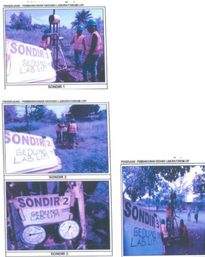
Gambar 3. Pelaksanaan Pekerjaan Tanah Sondir
