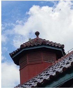
Gambar 8. Menara /tower pada atap bangunan
