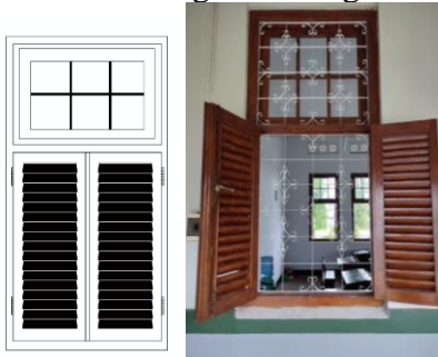
Gambar 4. Krepyak pada bukaan bangunan
