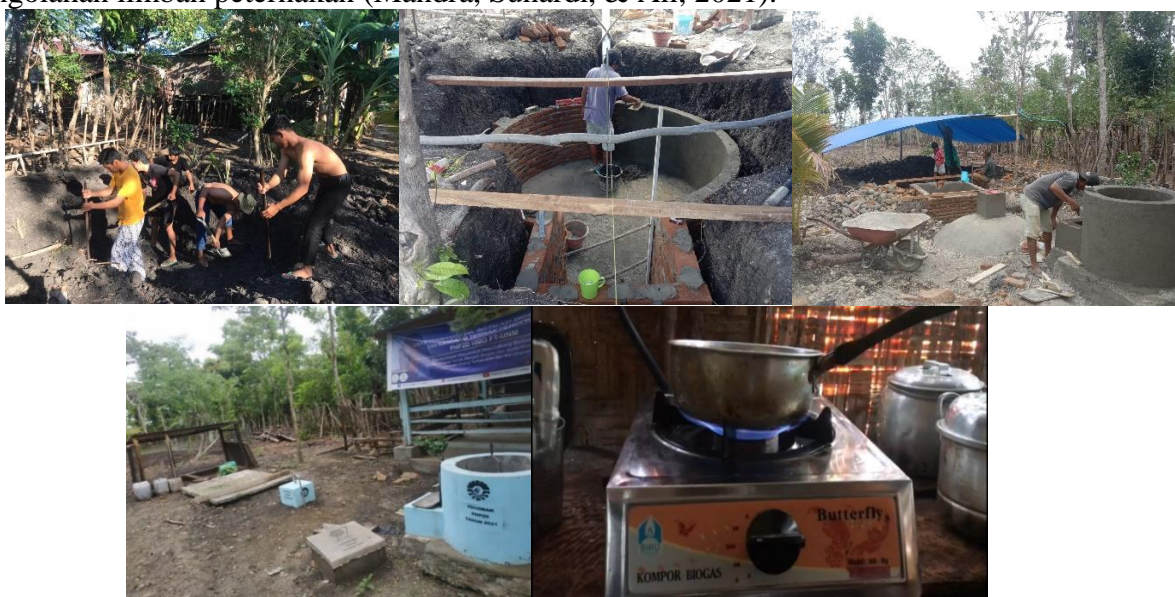
Gambar 2. Proses Pembuatan Instalasi Digester Biogas
